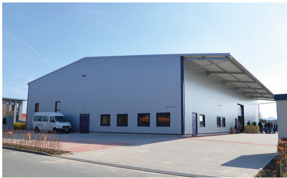
Lagerhalle HID II
