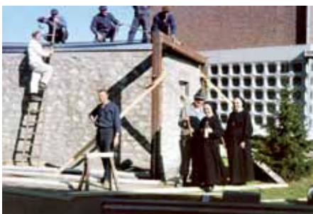
Bau des neuen Glockenturms vor der Kapelle.
